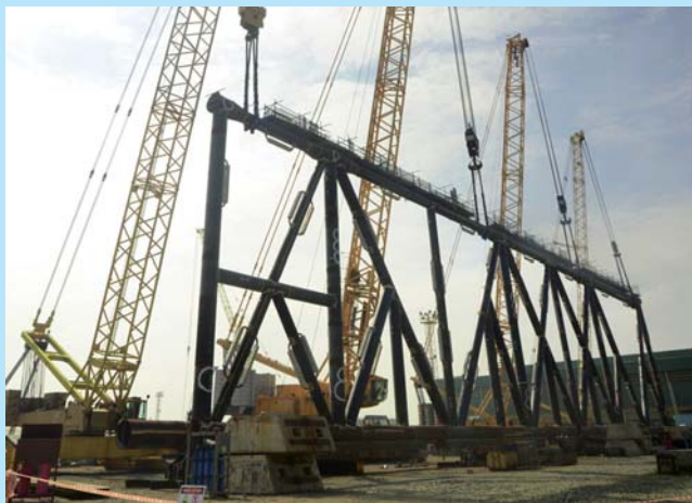
Panel Launch Truss 1 chân đế giàn BK Thiên Ưng. Ảnh: PVC
