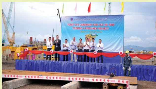
Nghi thức khởi công chế tạo khối thượng tầng giàn khai thác H5 và hệ thống đường ống nội mỏ Tê Giác Trắng. Ảnh: PVEP
