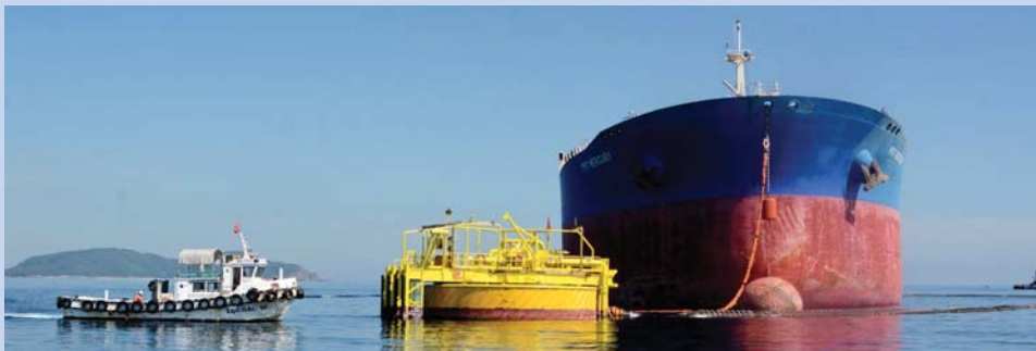
Bơm dầu thô từ tàu có tải trọng 150.000 tấn tại SPM của Nhà máy Lọc dầu Dung Quất. Ảnh: BSR
