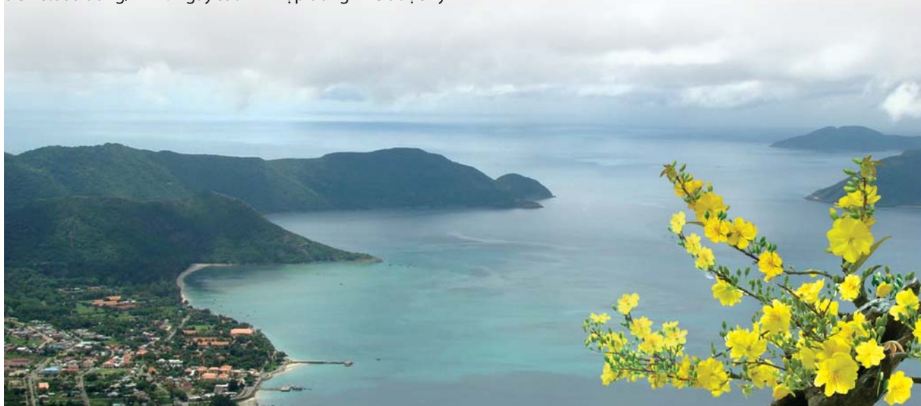
Nhà máy điện gió huyện Côn Đảo được xây dựng tại vịnh Côn Sơn, tỉnh Bà Rịa - Vũng Tàu. Ảnh: CTV
