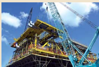
Lắp dựng thành công sàn Main Deck (phần 3). Ảnh: PVC
