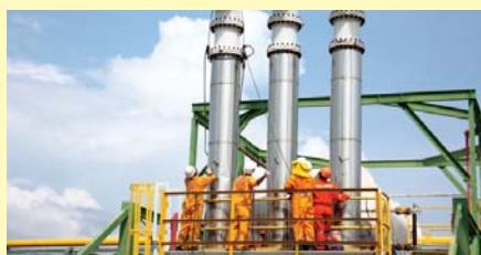
Cán bộ, kỹ sư Công ty Khí Cà Mau thực hiện bảo dưỡng công trình khí. Ảnh: CTV
