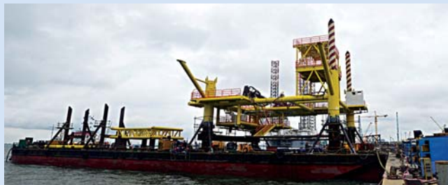
Sàn khoan giàn đầu giếng Kim Cương được hạ thủy an toàn, đúng tiến độ. Ảnh: PVC
