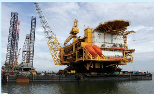
Khối thượng tầng giàn xử lý trung tâm mỏ Hải Thạch được hạ thủy thành công xuống sà lan S-45. Ảnh: PTSC
