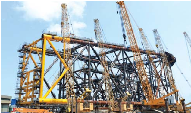
Panel Row 1 (Part 2) chân đế Thiên Ưng được lắp dựng thành công. Ảnh: PVC
